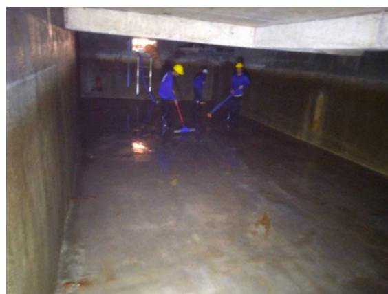
รูปที่ 2-16 การทำความสะอาดถังสำรองน้ำใช้
