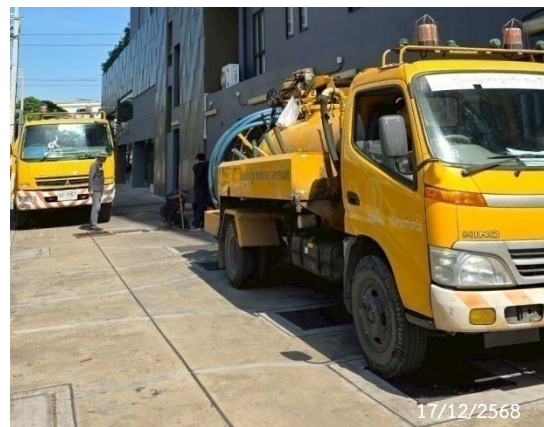
รูปที่ 2-20 การสูบล้างปลั๊กและกากไขมัน
