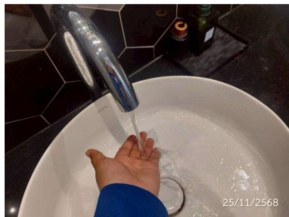
รูปที่ 2-14 ก๊อกน้ำเปิด-ปิด แบบอัตโนมัติ
