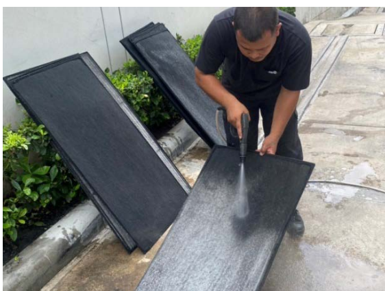
รูปที่ 2-40 การล้างทำความสะอาดแผ่นกรอง เครื่องปรับอากาศ
