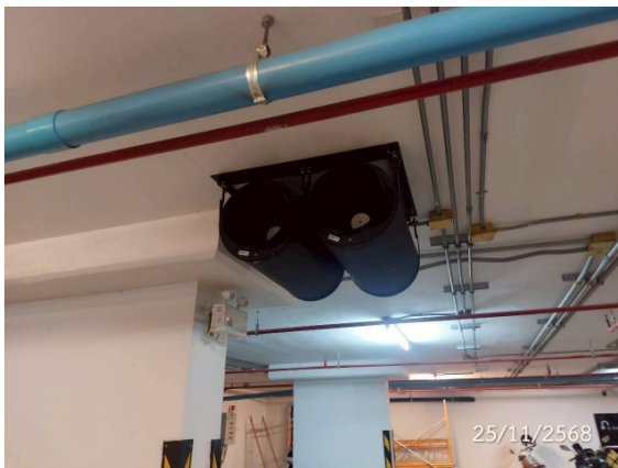
รูปที่ 2-56 พัดลมระบายอากาศ
