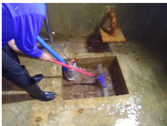
รูปที่ 2-16 การทำความสะอาดถังสำรองน้ำใช้
