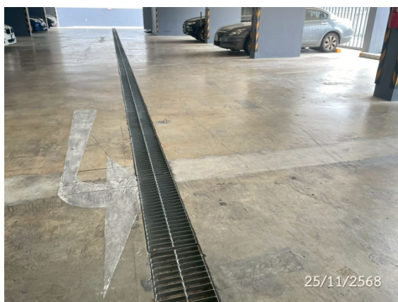
รูปที่ 2-62 ตะแกรงครอบท่อระบายน้ำ
