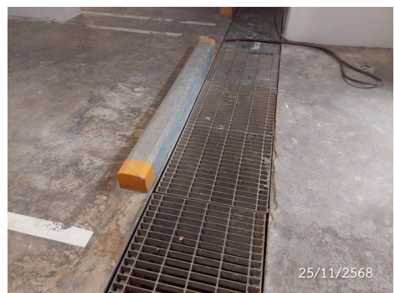
รูปที่ 2-62 ตะแกรงครอบท่อระบายน้ำ
