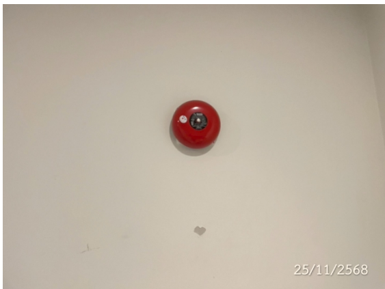
อุปกรณ์ส่งสัญญาณแจ้งเหตุ Alarm Bell
